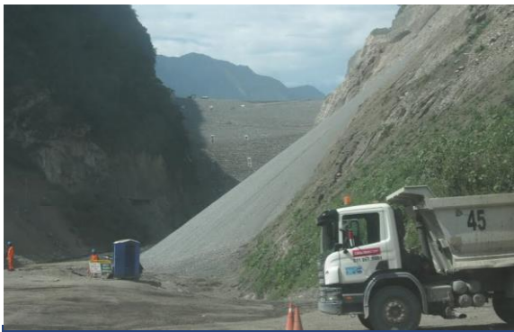
Usina de Chaglla
