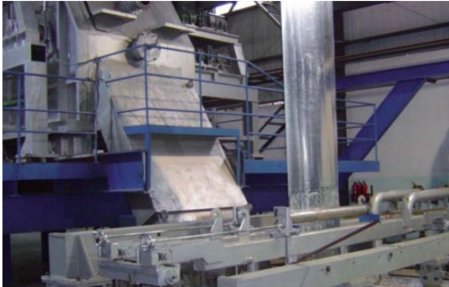
Fig 3. Linha de Galvanização Contínua [5,6]
